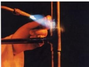
Das Hartlöten wird hauptsächlich zum Verbinden von Kupferrohren und Rohren aus unlegierten Stählen in allen Positionen eingesetzt. Der wirtschaftliche Einsatz dieses Verfahrens ist üblicherweise durch Wanddicken bis 2 mm begrenzt. Es eignet sich vor allem für den Einsatz auf Baustellen.
